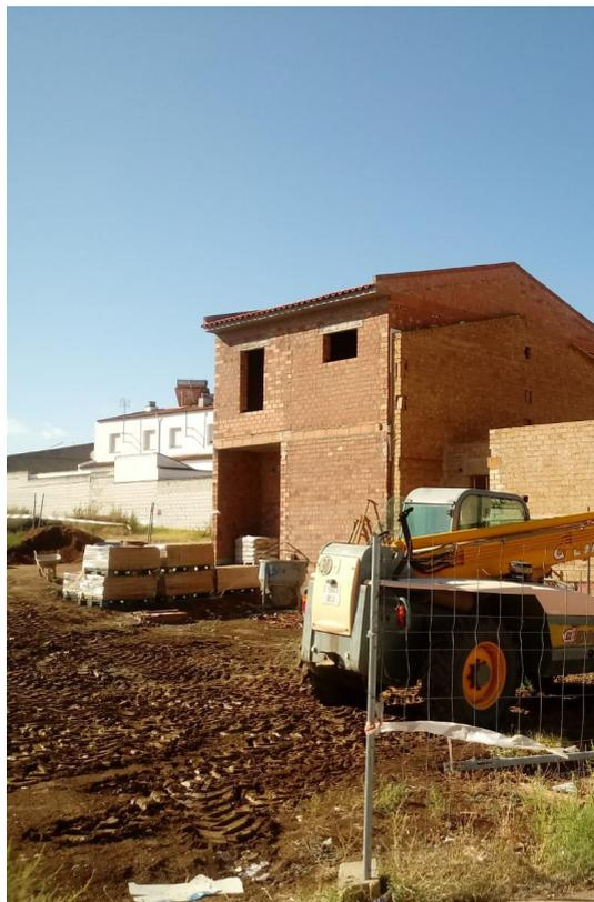
Cubierta ejecutada mediante rasillones cerámicos y fábricas aligeradas tipo tabique palomero de ladrillo hueco doble, alternadas con fábrica de 1/2 pie de ladrillo perforado. Sobre esta formación de pendiente se dispone un tablero machihembrado, capa de compresión y cubrición con teja cerámica mixta. Aislamiento de panel lana mineral con barrera vapor incorporada
