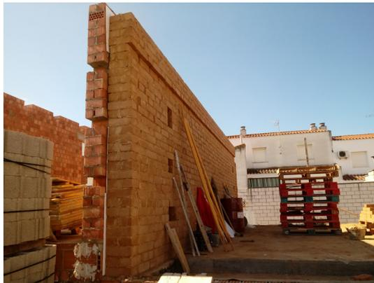
Muros de carga realizados con fábrica de BTC con tierras de la zona
