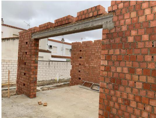
Muros de carga realizados con fábrica de ladrillo
