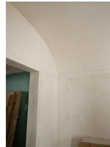
Ejecución revestimientos mortero arcilla sobre BTC
