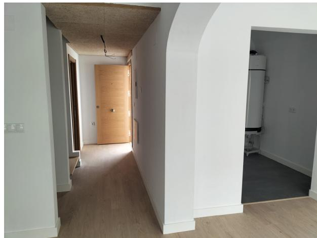
Ejecución falso techo paneles de fibra de madera
