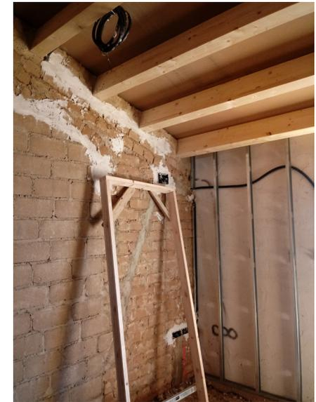
Vista entramado de madera formado por vigas, correas y tablero de partículas hidrofugado
