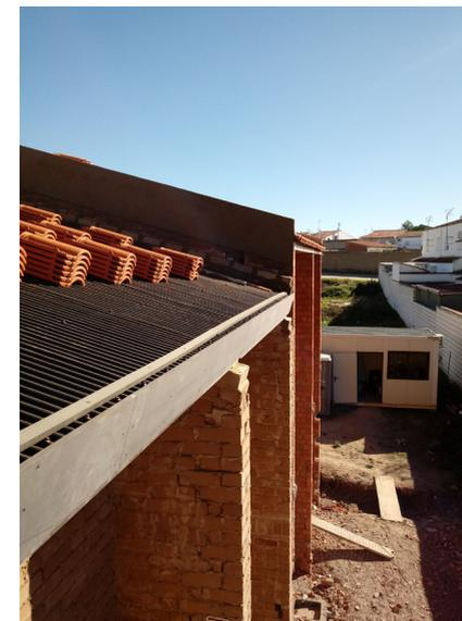
Colocación placa de cemento reforzado EURONIT o equivalente y teja cerámica
