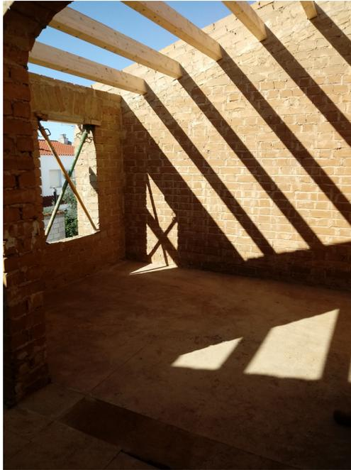
Ejecutado el entramado de madera formado por vigas, correas y panel sandwich sobre el que se colocará la teja cerámica
