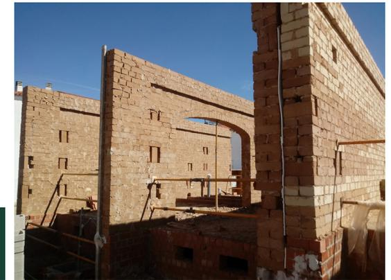
Muros de carga realizados con fábrica de BTC con tierras de la zona
