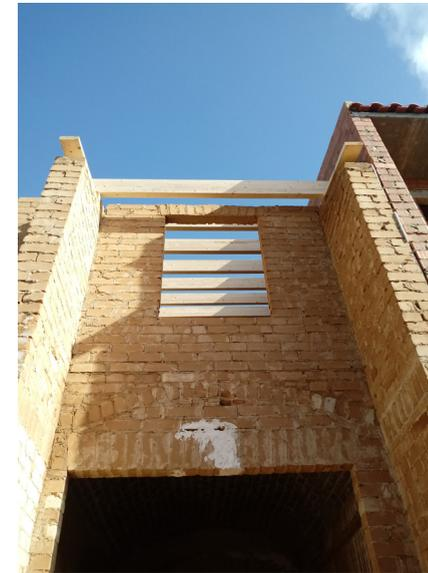
Ejecutado el entramado de madera formado por vigas, correas y tablero de partículas hidrofugado de la cubierta
